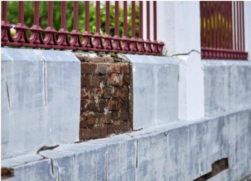
“Las molduras y detalles superiores de los pórticos no se van a decapar y la tapia perimetral recibirá el resane de grietas, impermeabilización y pintura, al igual que las rejas perimetrales, las cuales ya cuentan con una primera capa de minio rojo”, anotó la arquitecta Salas.
