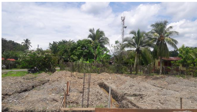
Construcción de la Biblioteca Pública de Matina
